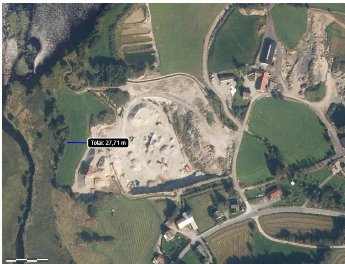
Figur 2-5. Flyfoto (2019) over sandtaket og nærliggende infiltrasjonsmark med en bredde på om lag 27 meter.
